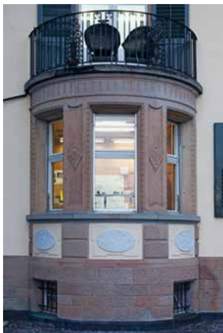
Abb. 1 Erker Erdgeschoss Südwest- fassade
